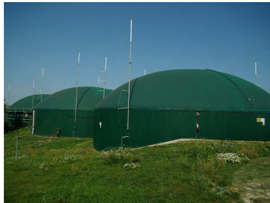
Przedmiotem działalności spółdzielni energetycznej jest wytwarzanie energii elektrycznej, biogazu lub ciepła w instalacjach odnawialnego źródła energii.
