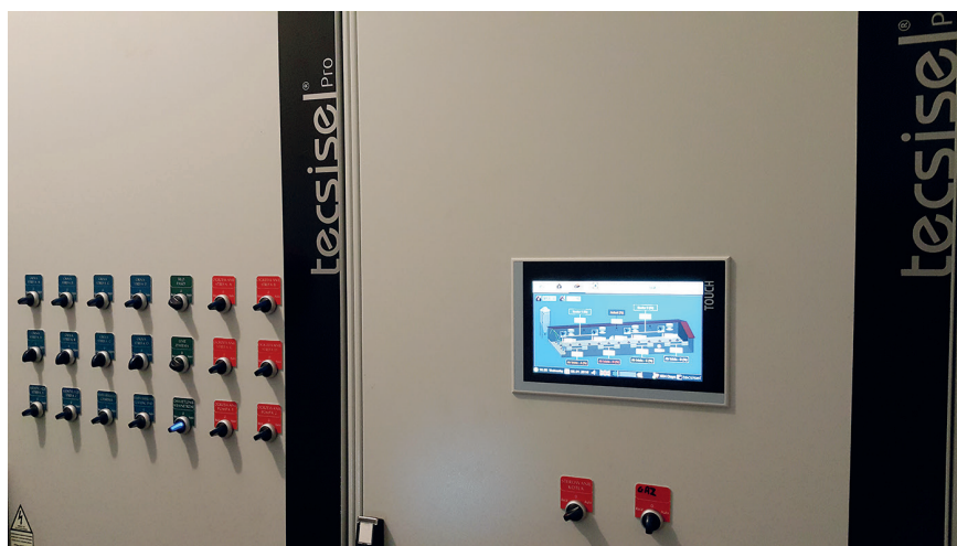
Systemem wentylacji poprzecznej steruje komputer przemysłowy
